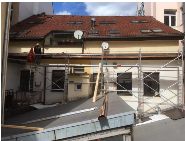
Výměna poškozených okapových svodů v dubnu 2022
