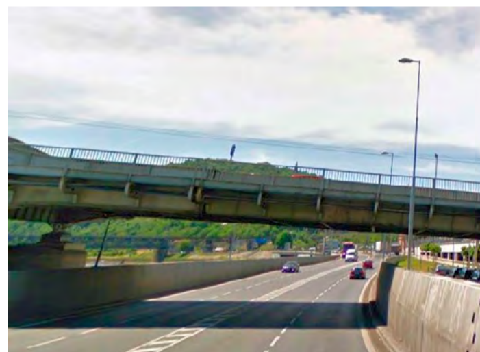
Nové semafony budou reagovat i na monitoring protipovodňové vany
